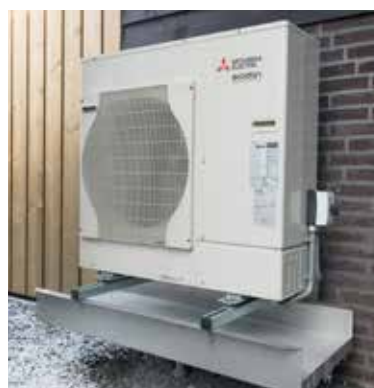
Aan de onderzijde van de buitenunit loopt condenswater weg. Door middel van een lekbak en/of een grindpakket kan dit worden opgevangen.
