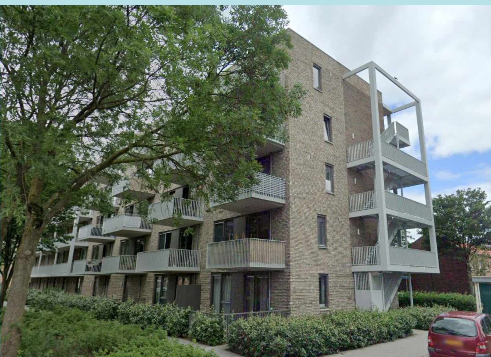
Appartementen Dirk Hartogstraat Lichte beige baksteen | staal | licht hekwerk
