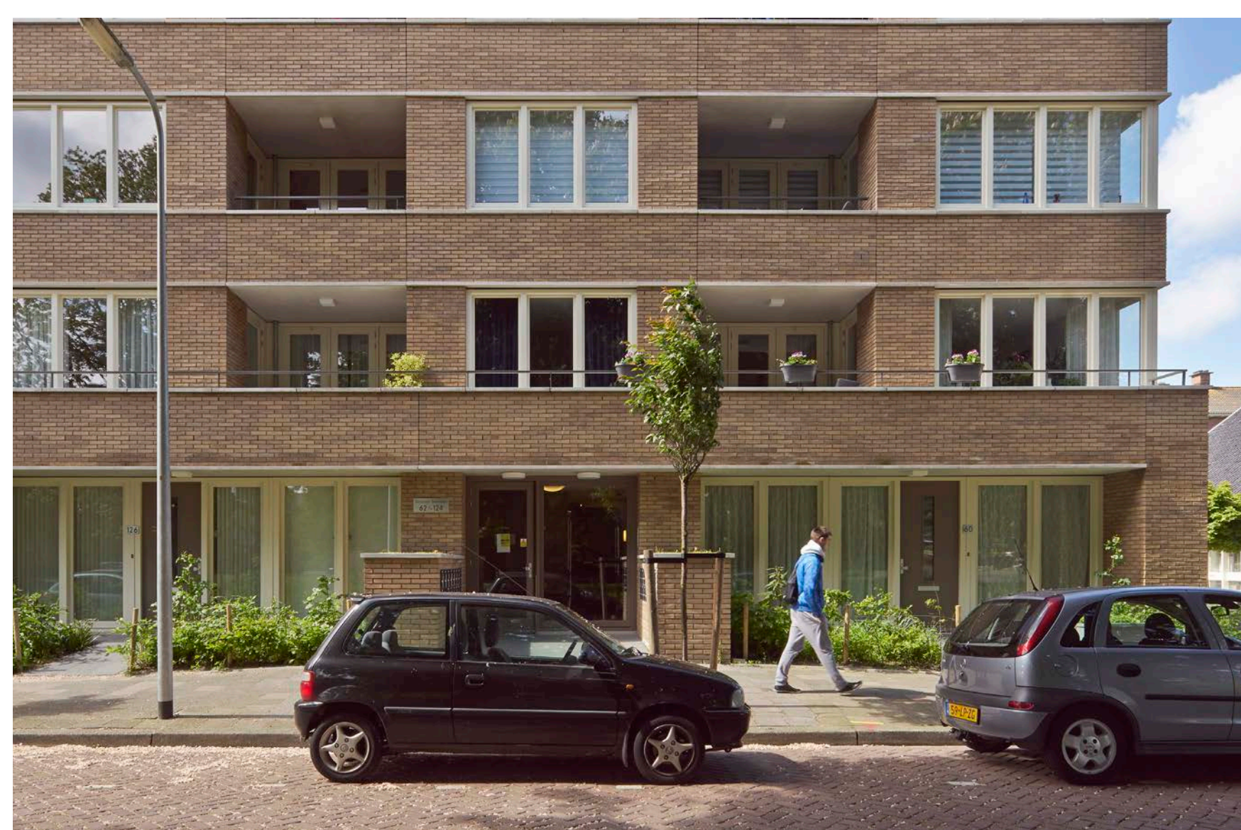
Appartementen met inpandige balkons (loggia's) Baksteen | witte kozijnen | baksteen balustrades
