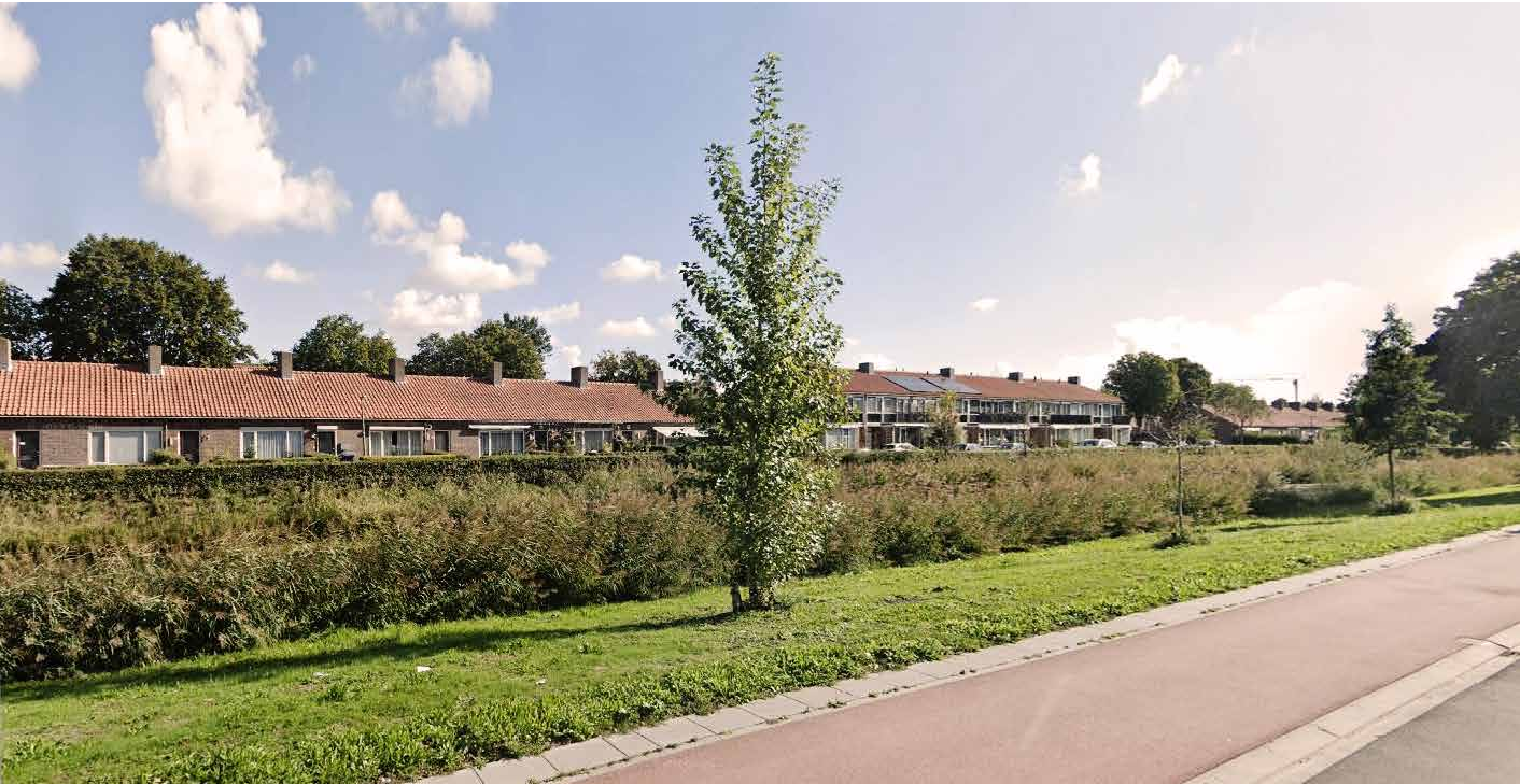
Bestaande situatie gezien vanaf overzijde Boschmeersingel met rijtjeswoningen
