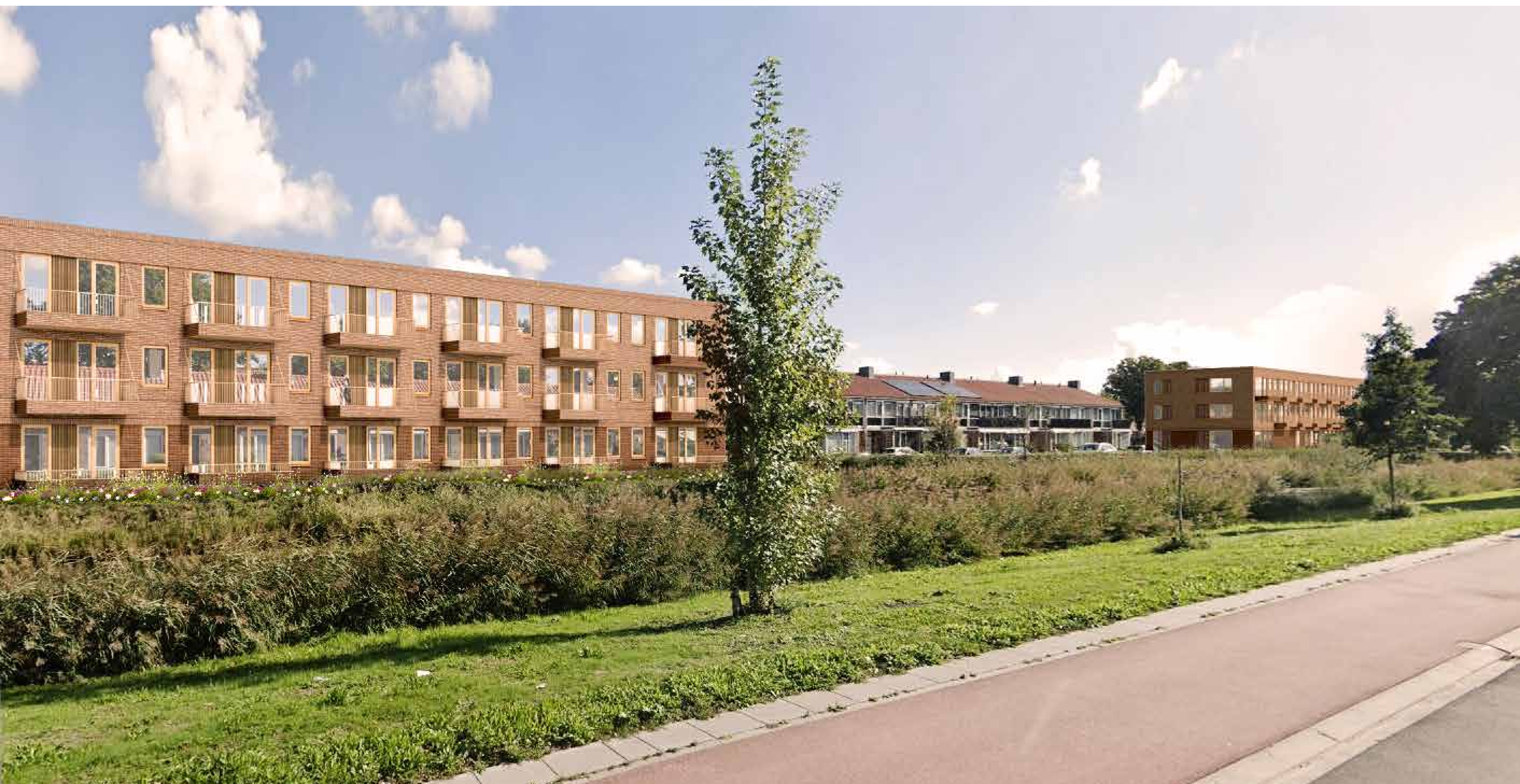
Nieuwe situatie gezien vanaf overzijde Boschmeersingel met op de voorgrond blok B en op de achtergrond blok A
